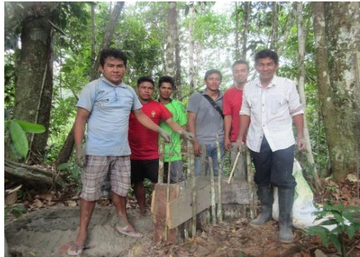
Cimentación de hito 5
